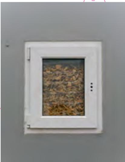
Bild: Ein Blick in eine Hackschnitzelheizung - Durch ein Fenster kann man den Füllstand sehen.
